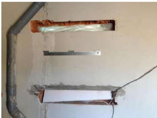
3. Montaż konsoli ściennej
