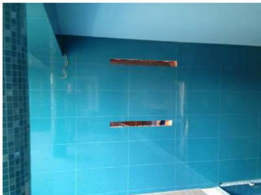
1. Cięcie przejść ściennych
