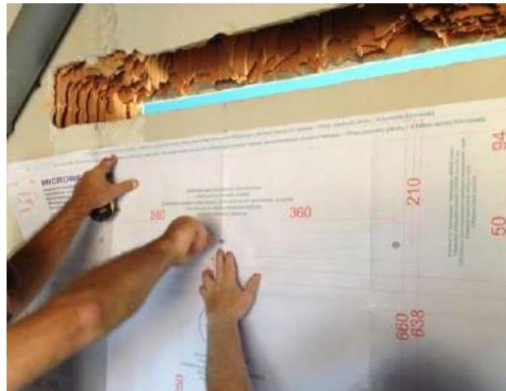
2. Pomiar konsoli przy użyciu szablonu
