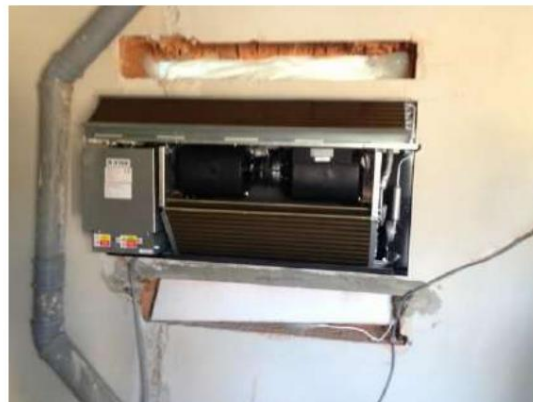
3. Montaż konsoli ściennej
