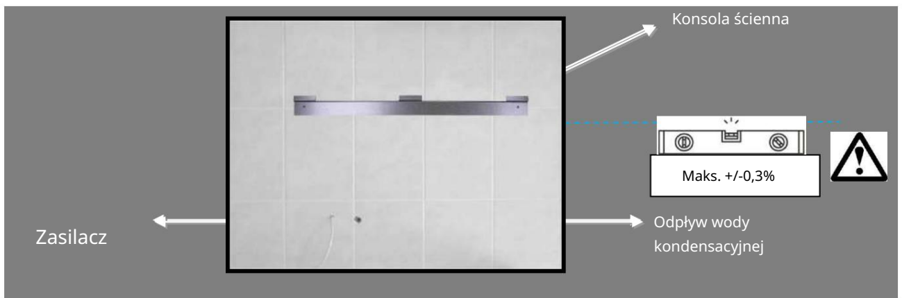
Fot.: Przygotowanie instalacji DRY 500
